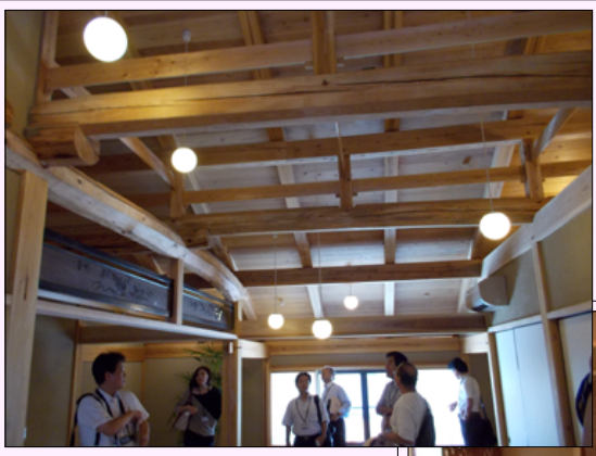
＊平成の京町家普及センター＊ 伝統構法2階建て 京都産木材で建設されています
